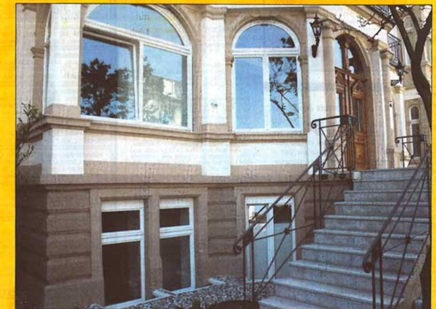
Hereinspaziert: Massive Eichentüren führen zu den beiden Eingängen.
