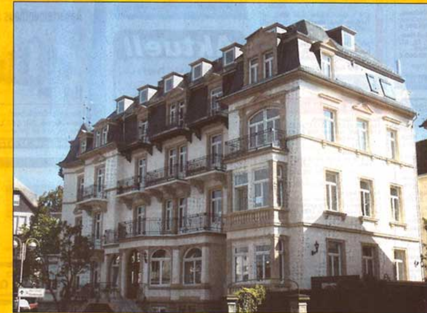
Umfangreiche Sanierungsarbeiten verwandelten die »Villa Royal« in ein Juwel zurück.
